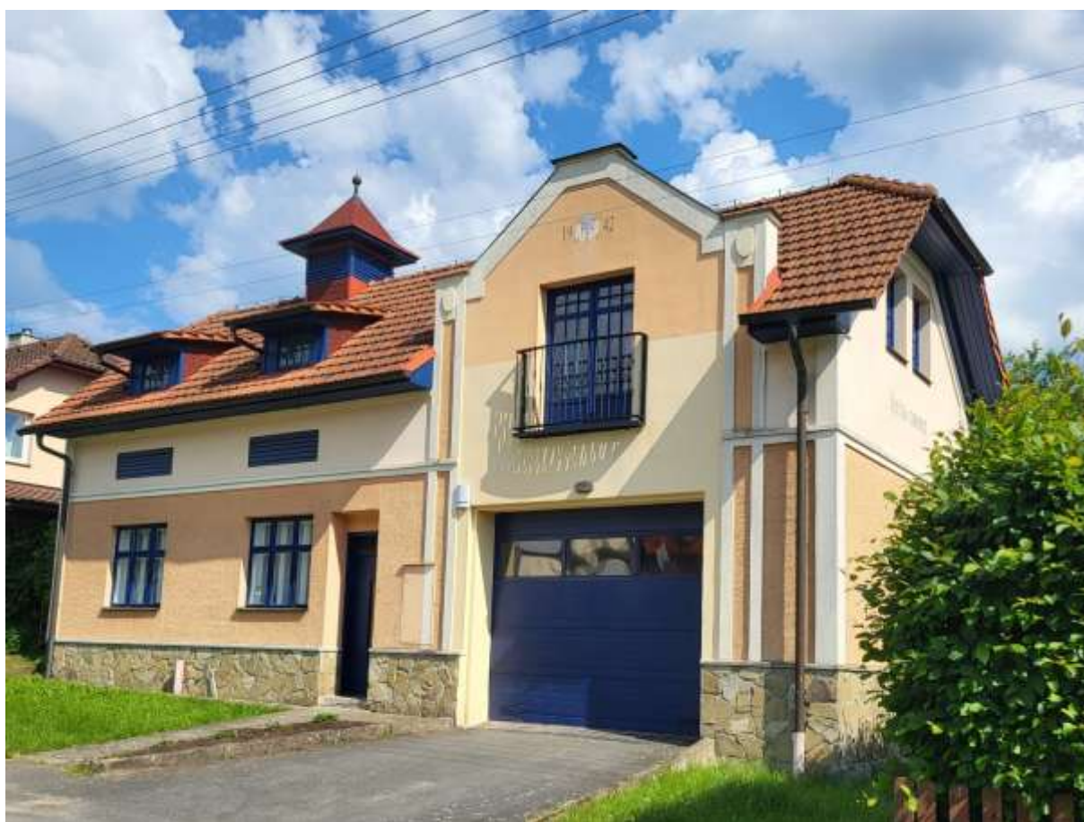
Obr. č. 9: Hasičská zbrojnice
