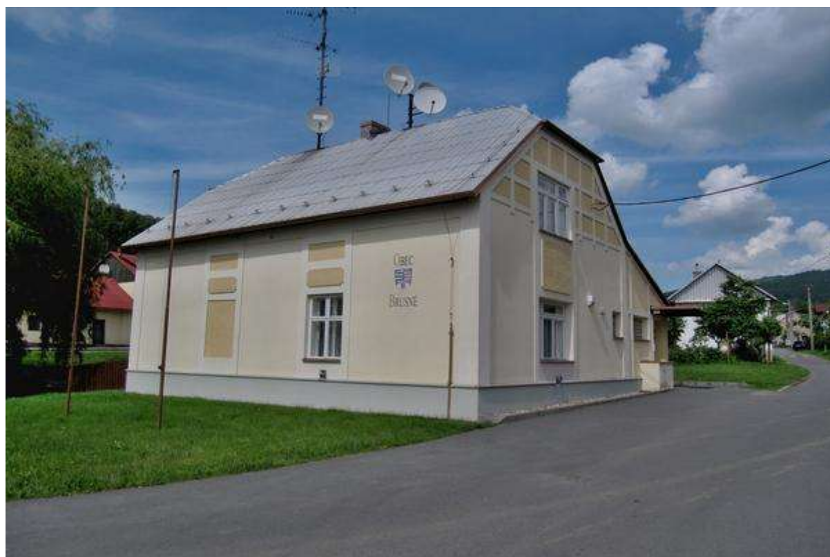
Obr. č. 23: Budova Obecního úřadu v obci Brusné
